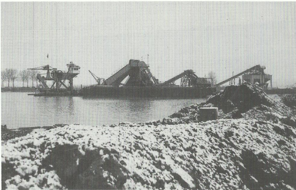
Baggerwerkzaamheden in het "Maasnielder gat".
