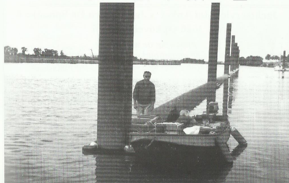
George, Nes en Jo bij de montage van de nieuwe "optuigsteiger"
