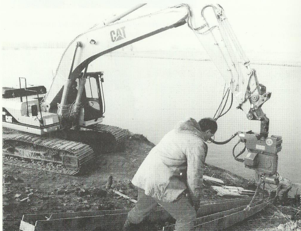
Begin werkzaamheden bij het "bastion".
