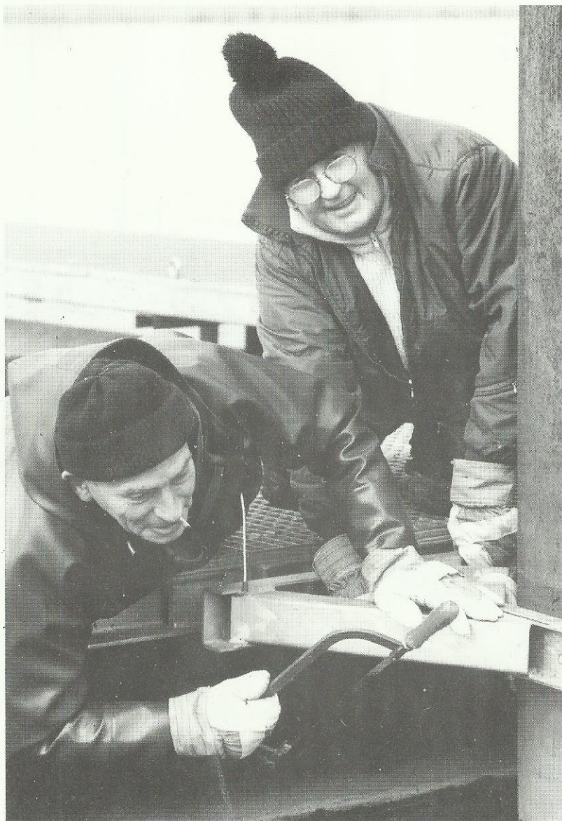
Her-montage van de steigers. Jo Heijnen en Lothar Schmidt, harde werkers van het eerste uur (met speciale ijzerzaagtechniek).
