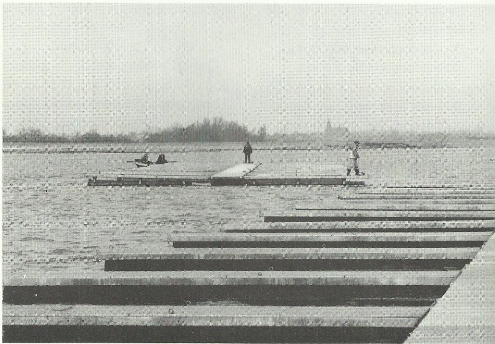
De steigers worden weggeslept en tijdelijk verankerd. Het grootste karwei in de geschiedenis van Ascloa begint.
