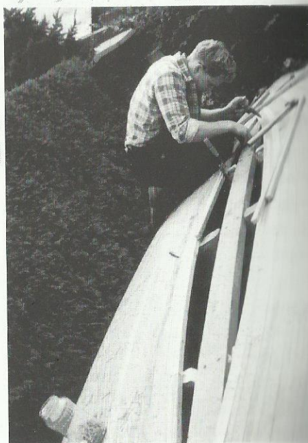
Grondige renovatie van een BM thuis in de tuin
