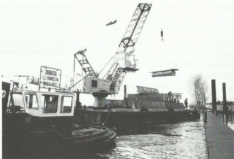
De nieuwe steigers worden op hun plaats gelegd
