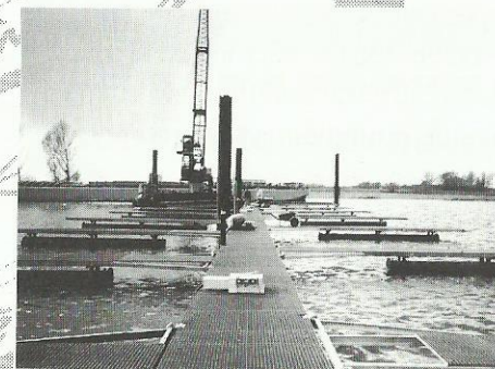
Montage van de nieuwe steigers en de stroomkasten
